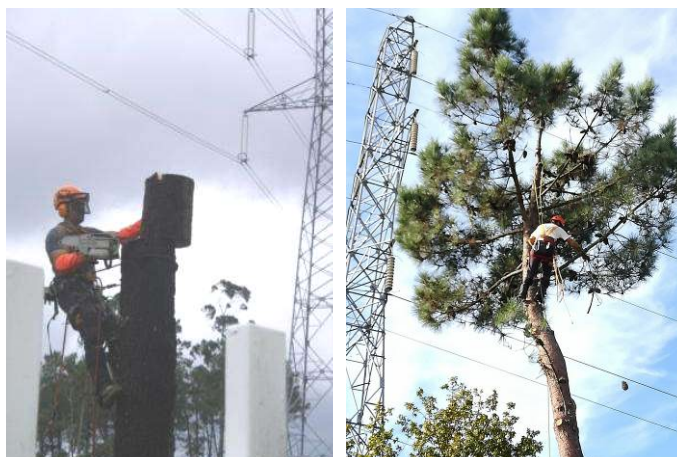
Figura 28 - Desmontagem de árvores, com recurso a técnica de escalada (arboricultura)
