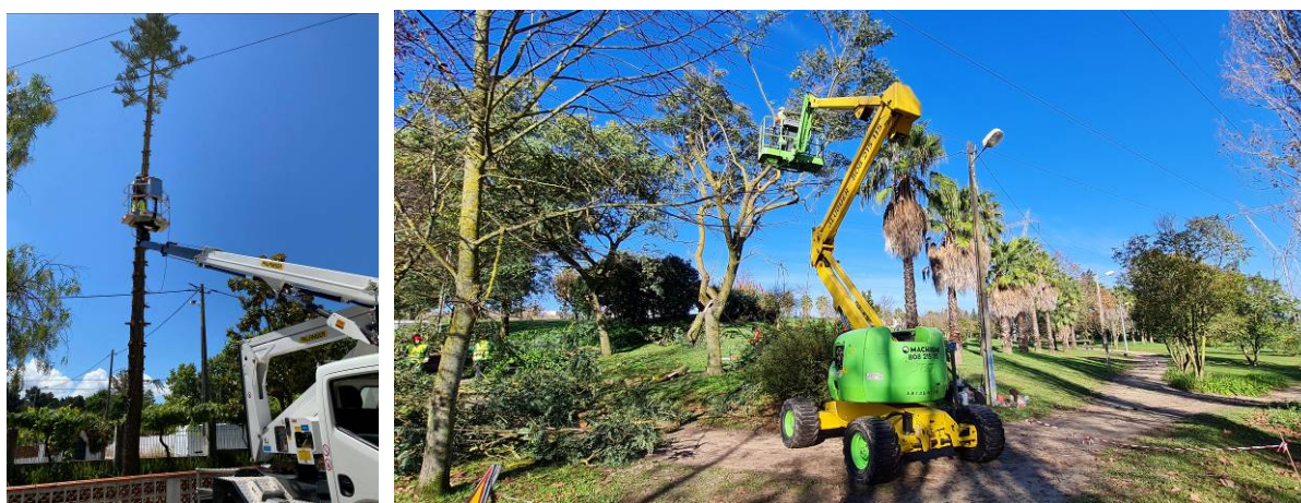
Figura 29 - Desmontagem de árvores, com recurso a grua e a plataforma elevatória
