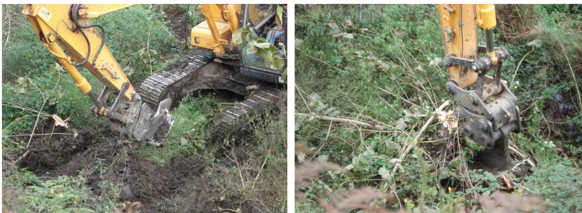
Figura 2 - arranque e enterramento de cepos com enxó
