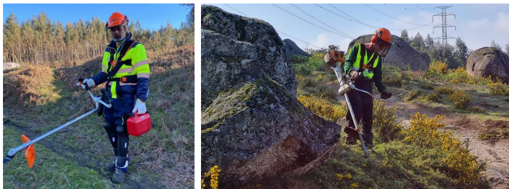
Figura 36 - Limpeza de matos motomanual
