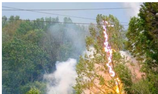
Figura 15 - Danos provocados pelo incumprimento das distâncias mínimas de segurança.
