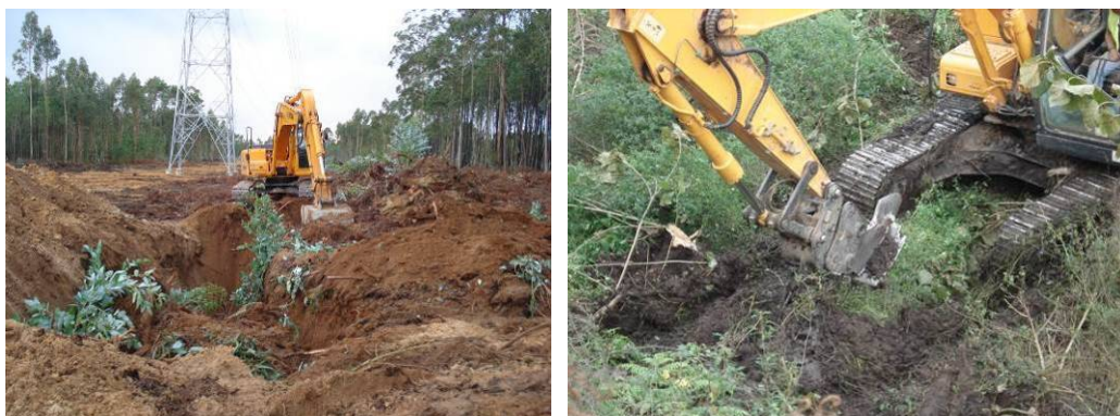
Figura 43 - Eliminação de cepos
