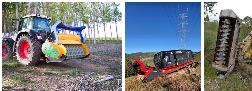
Figura 40 - Limpeza de matos mecânica: exemplos de destroçadores de martelos acoplados a diferentes máquinas
