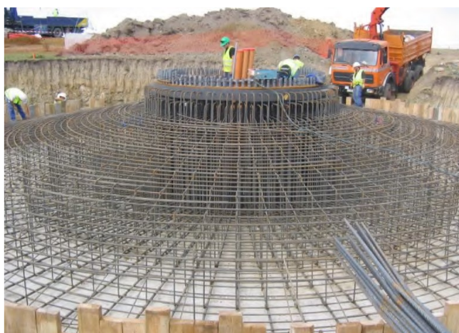
Figura 3. Construção da sapata de um aerogerador.
