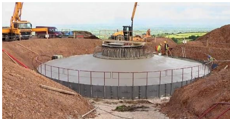
Foto 2-4 – Exemplo de uma fundação do aerogerador novo
