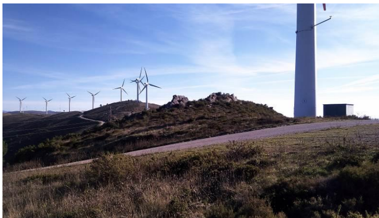
Foto 4-13 – Vista para o parque eólico (aerogeradores n.º 1 a 8), a partir da posição do novo aerogerador n.º 1
