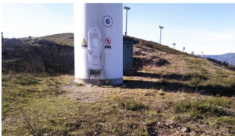
Foto 4-14 – Vista para o local do novo aerogerador n.º 2 (posição do aerogerador n.º 6)
