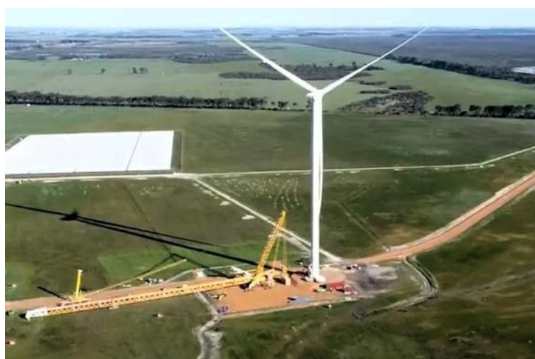
Foto 2-5 – Exemplo de fim de montagem de um aerogerador
