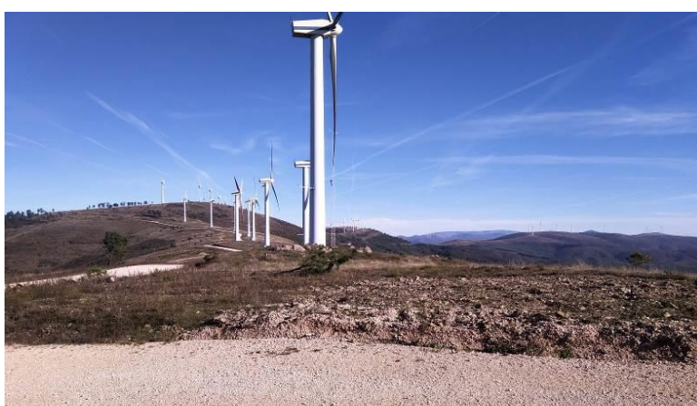
Foto 4-15 – Vista para o parque eólico (aerogeradores n.º 7 a 15), a partir da posição do novo aerogerador n.º 2
