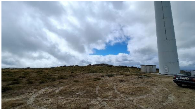
Figura 9 - Vista parcial do local onde se prevê o desmantelamento de aerogerador existente (AEG2) e deposição de terra vegetal (parga) (registro fotográfico efetuado a 02/09/2025).
