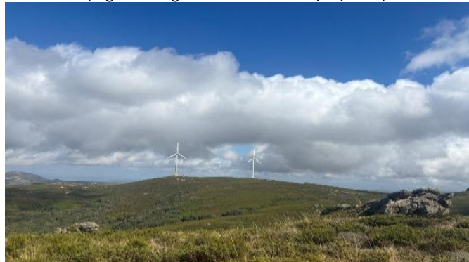
Figura 10 - Vista parcial do PE (AEG5 e AEG6) e do local previsto para a construção do AG3 (registro fotográfico efetuado a 02/09/2025).
