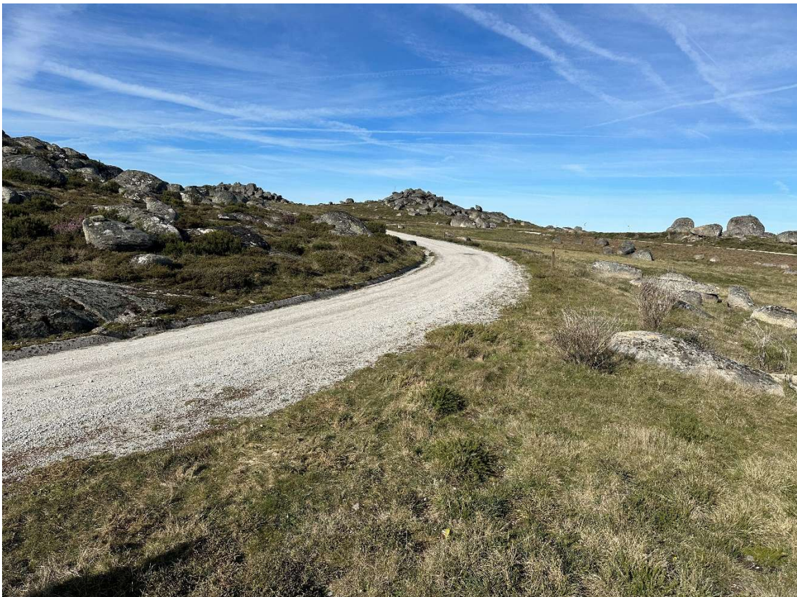
Figura 3.1 – Imagem geral do acesso existente
