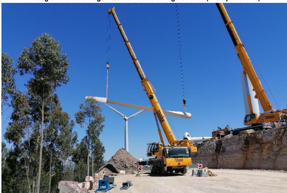
Fotografia 6 – Montagem da Torre dos aerogeradores (exemplificativo).
