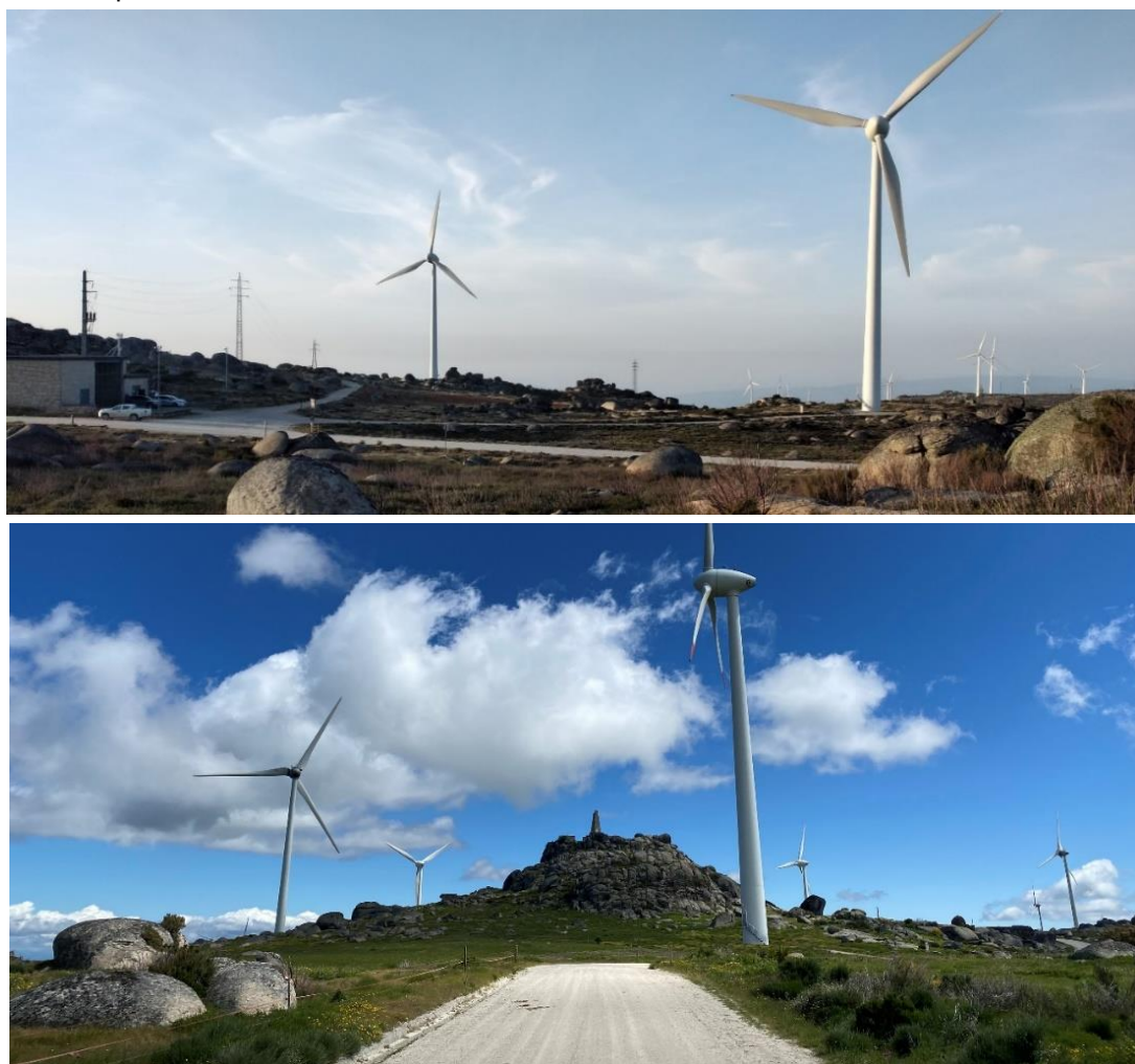
Fotografia 1 – Acesso Existente até ao local dos aerogeradores do Parque Eólico de Pinheiro.
