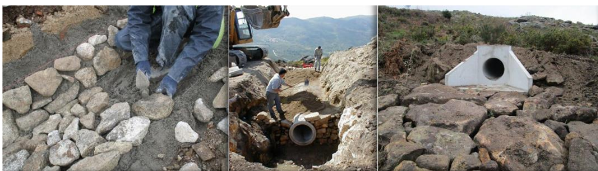
Fotografia 2 – Valeta e construção de uma passagem hidráulica (exemplificativo).
