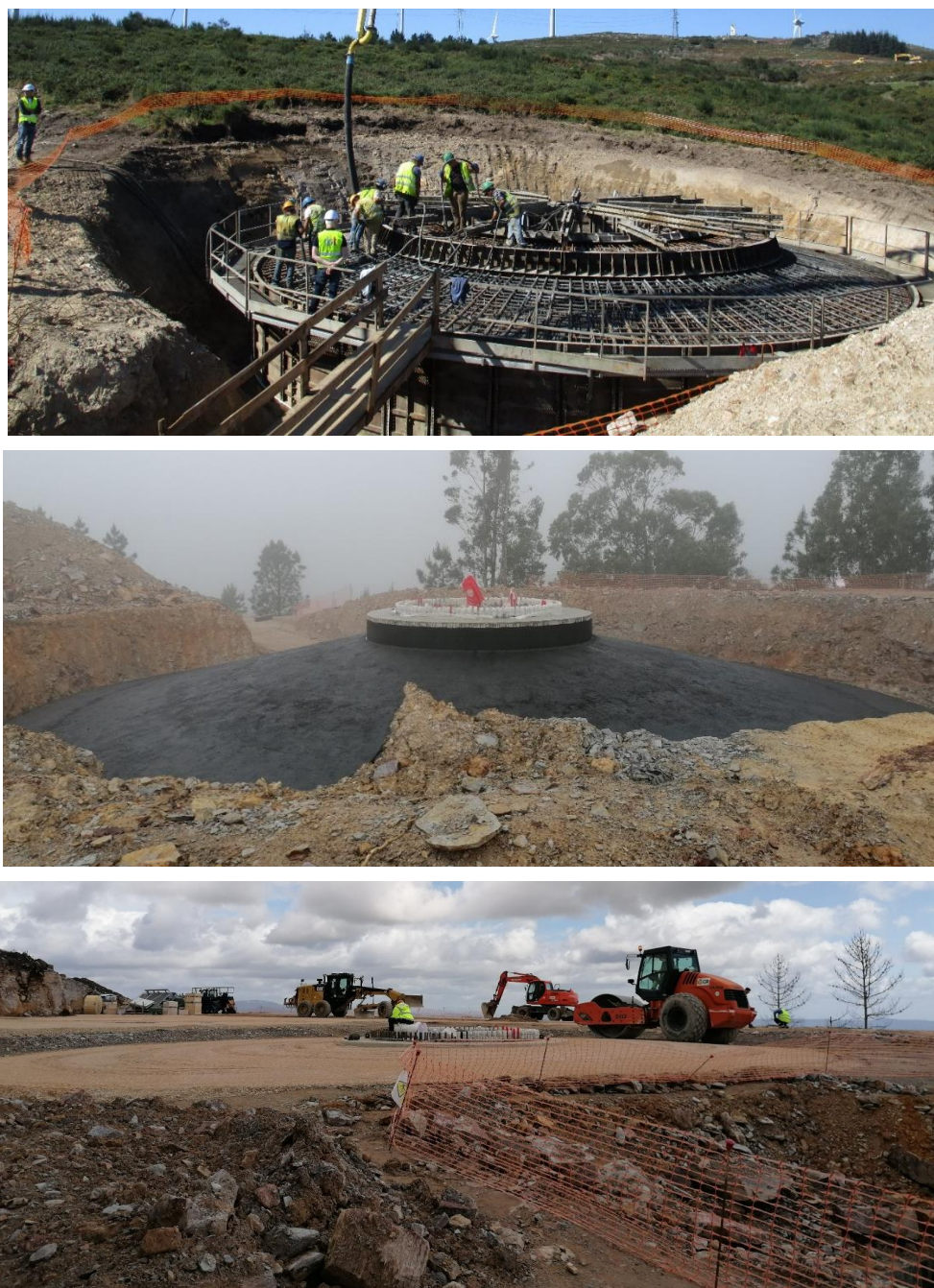
Fotografia 4 - Execução da fundação da torre de um aerogerador (exemplificativo).
