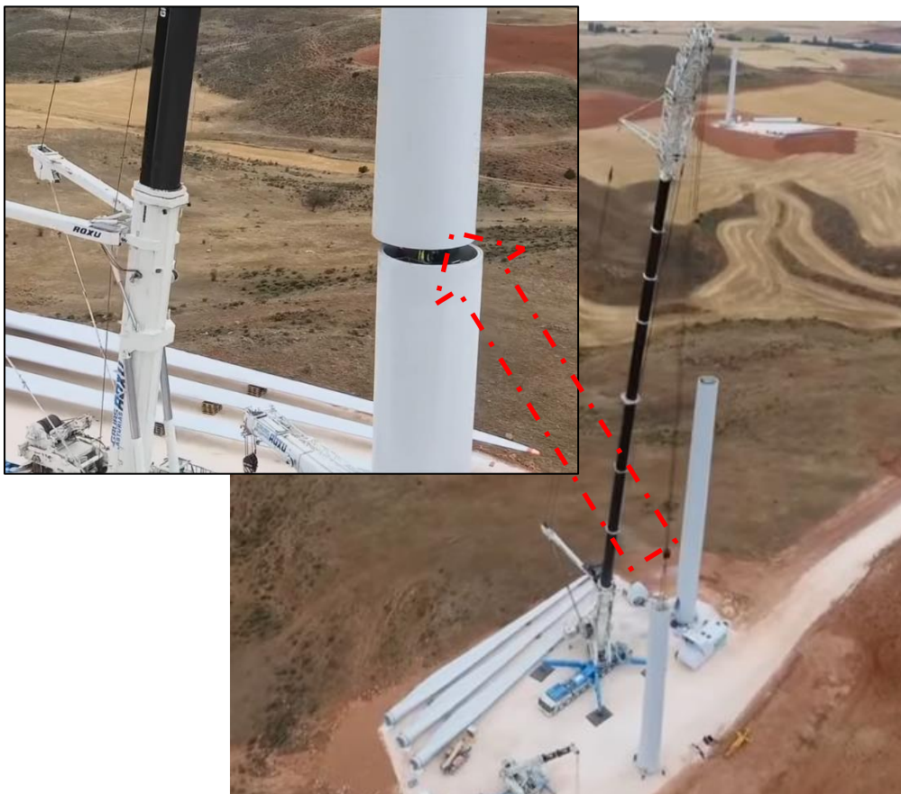
Fotografia 6 – Montagem da Torre dos aerogeradores (exemplificativo).
