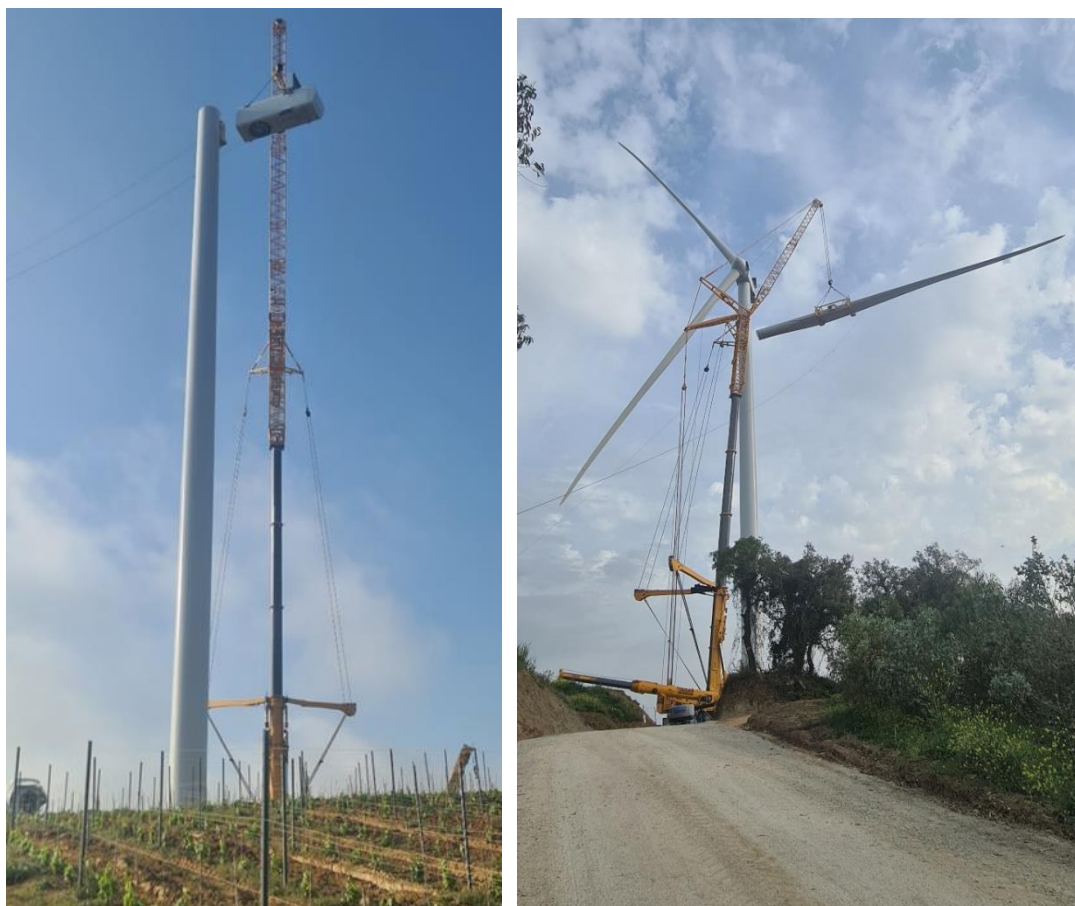
Fotografia 7 – Montagem das pás e nacelle (exemplificativo).
