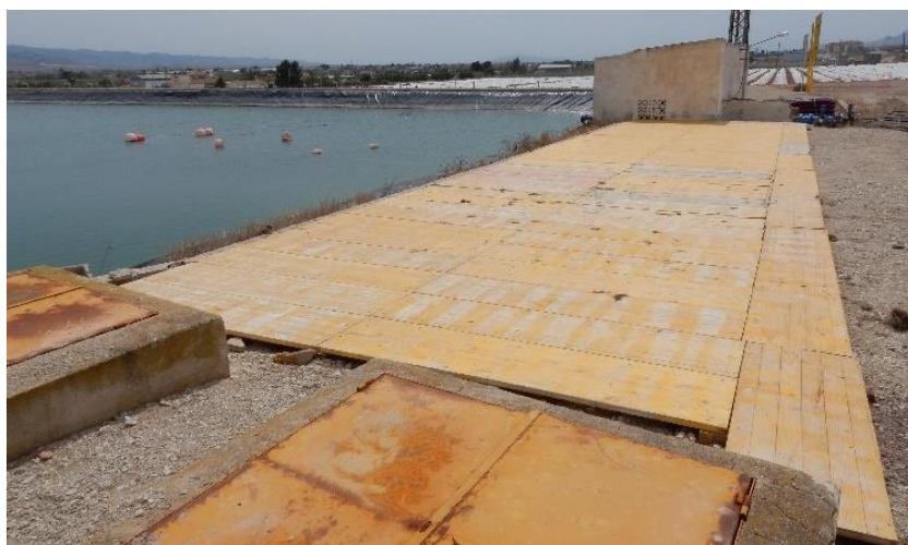
Figura 48: Plataforma de lançamento com pranchas de madeira
