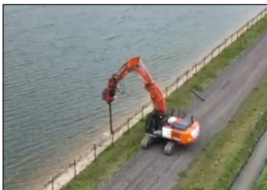
Figura 24: Máquina de cravação de estacas instalando uma âncora
