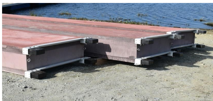
Figura 14: Ligações entre pontões
