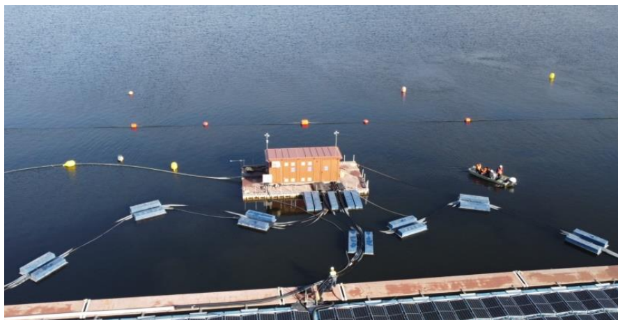
Figura 17: Cabo de saída da central para o CT
