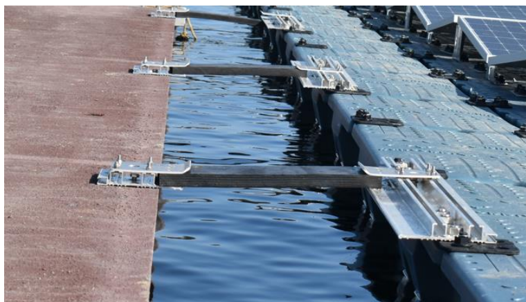
Figura 15: Ligação planta - pontões
