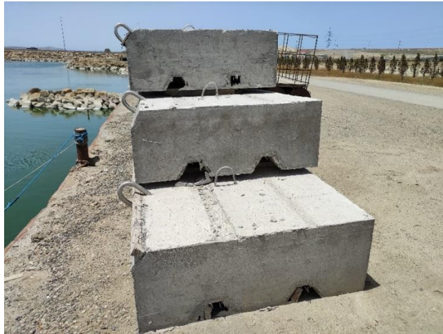
Figura 19: Ancoragens de fundo de betão
