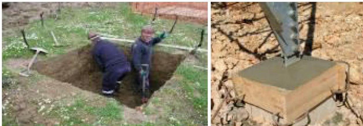
Fotografia 4.2 – Tipo de fundações para os apoios da Linha Elétrica a 400 kV.
