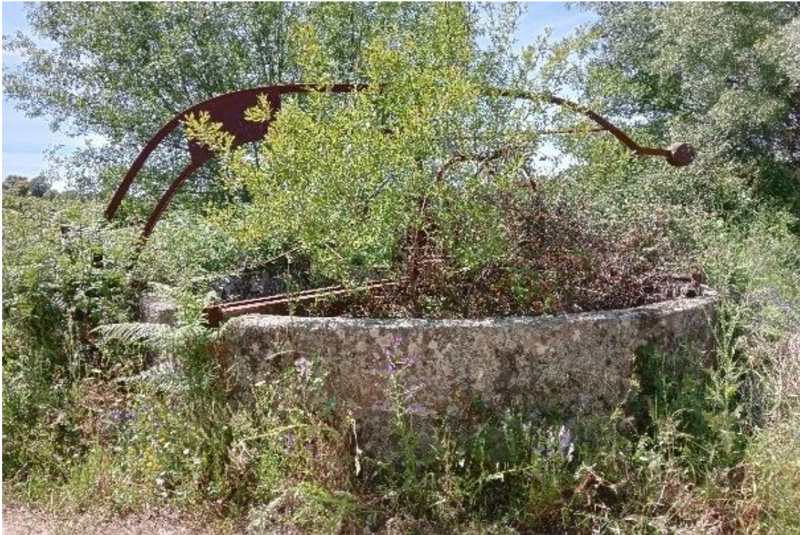
Fotografia 67 – Exemplo de um poço com engenho.
