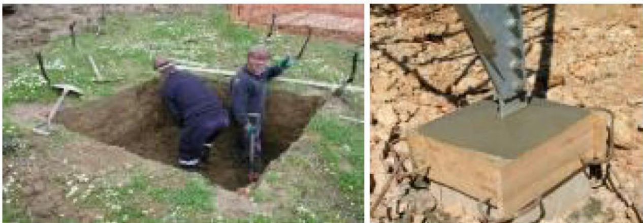
Fotografia 2.3 – Tipo de fundações para os apoios das Linhas Elétricas a 400 kV.
