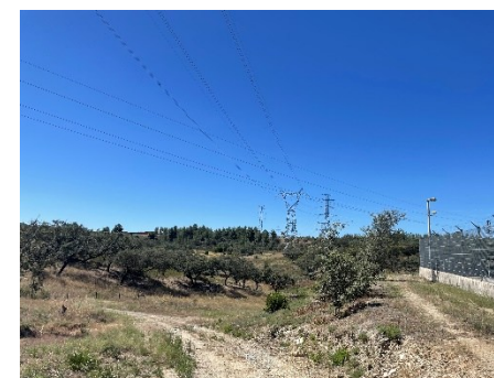
Infraestruturas Elétricas (chegada à SE de Castelo Branco)
