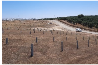
Desmatção, decapagem e cravação de perfis metálicos da estrutura seguidora
