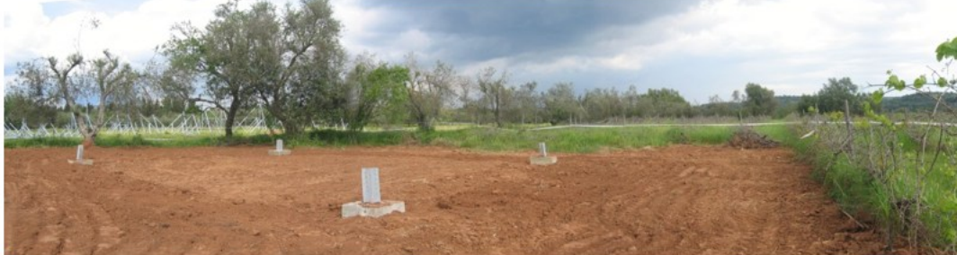
Execução das fundações dos apoios de linha
