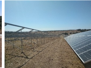
Desmatção, decapagem e cravação de perfis metálicos da estrutura seguidora
