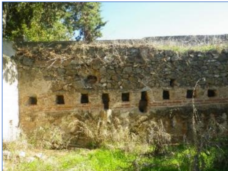
Figura 42 – Vista da Conduta de Água – lado Este
