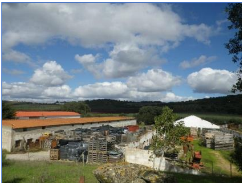
Figura 39 – Vista geral do Pavilhão 4
