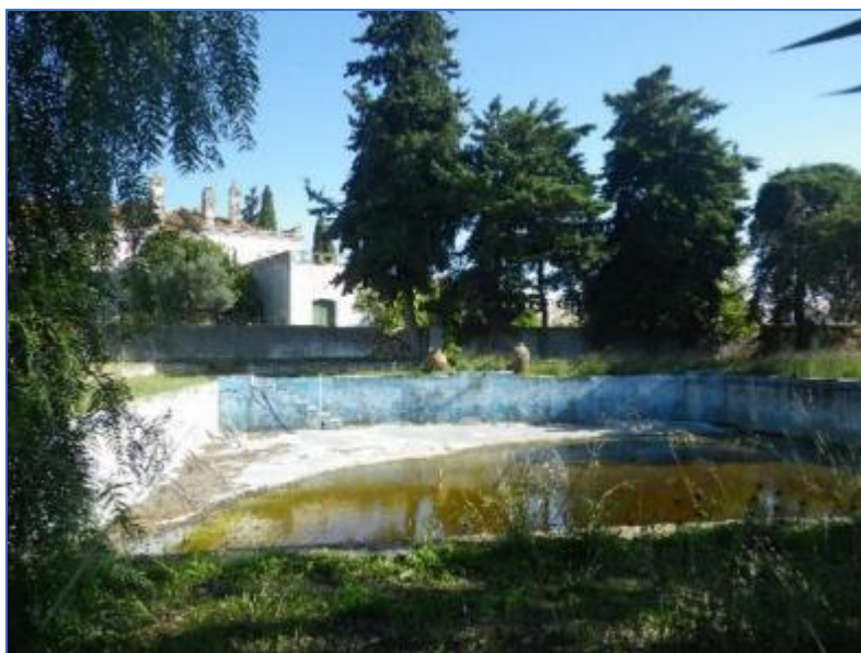
Figura 41 – Vista do Tanque
