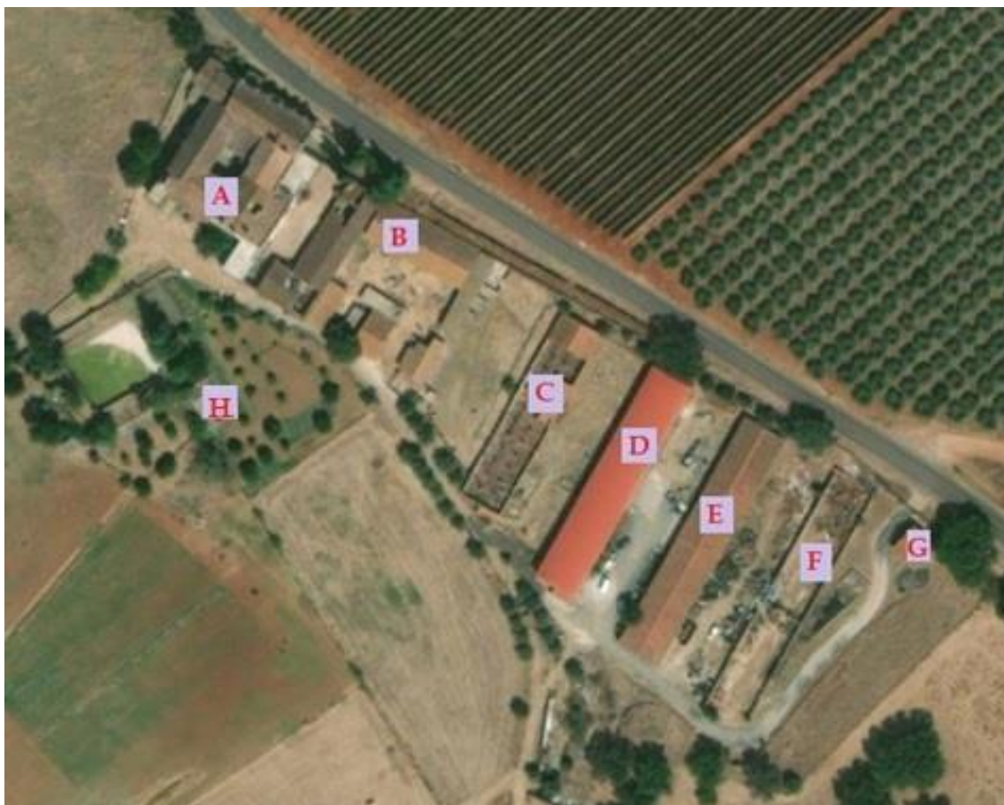
Figura 6 - Edifícios construídos no interior da área de incidência direta do projeto. (Fonte: Imagem de Satélite)
