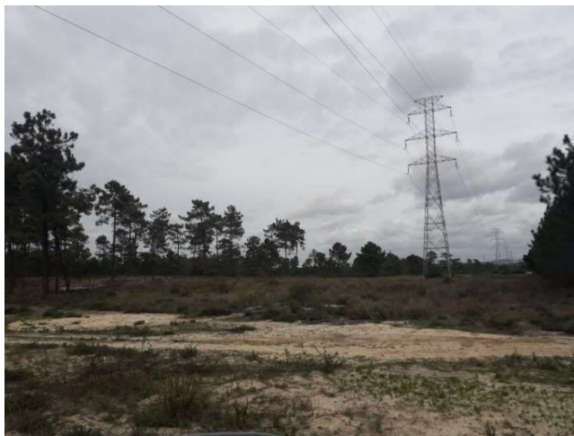
Foto IV. 10 – Área de Matos Rasteiros no Corredor de Linha Elétrica
