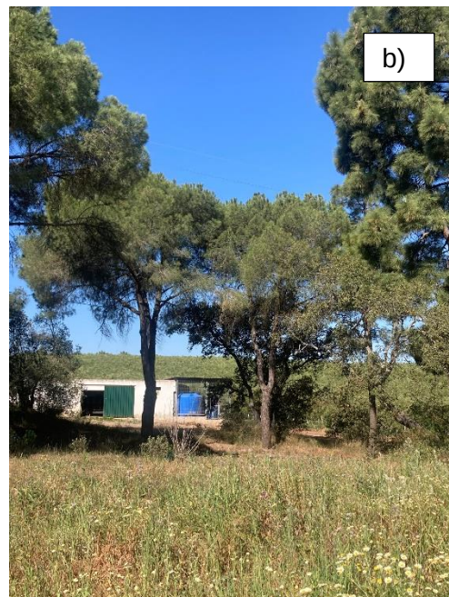
Figura 3.4 – (a) Parcela onde ficará localizada a câmara de válvulas no início do adutor; (b) casa de bombagem existente a jusante da EN2.
