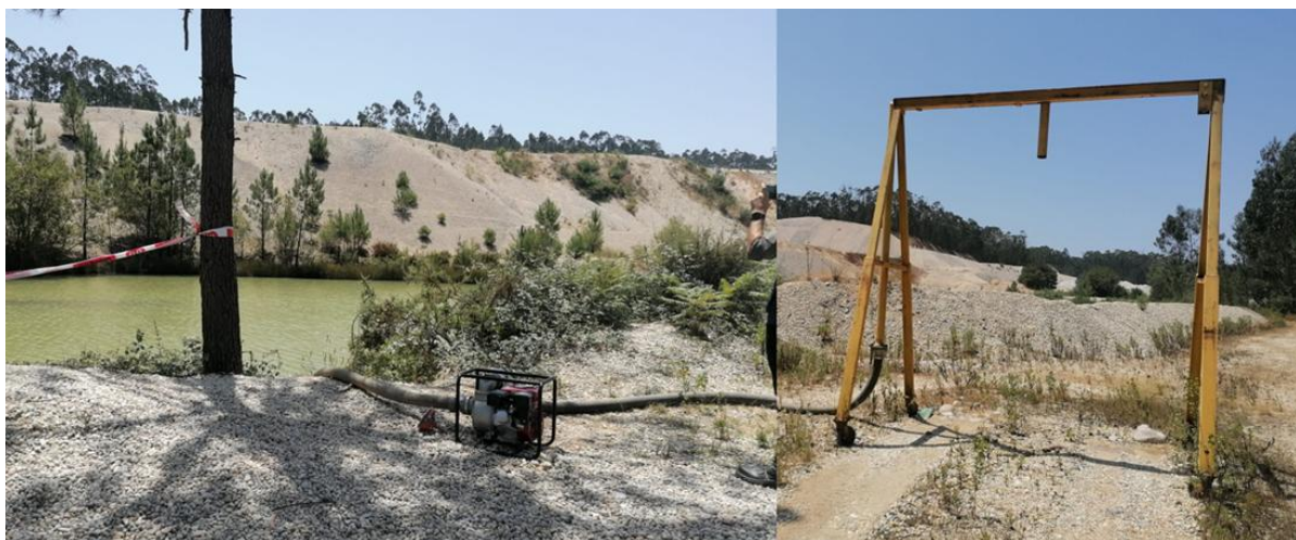
Figura 15 - Equipamento bomba para retirar água (visita técnica 02.07.2025)
