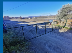
VEDAÇÃO E SINALIZAÇÃO EXISTENTE NA PEDREIRA
