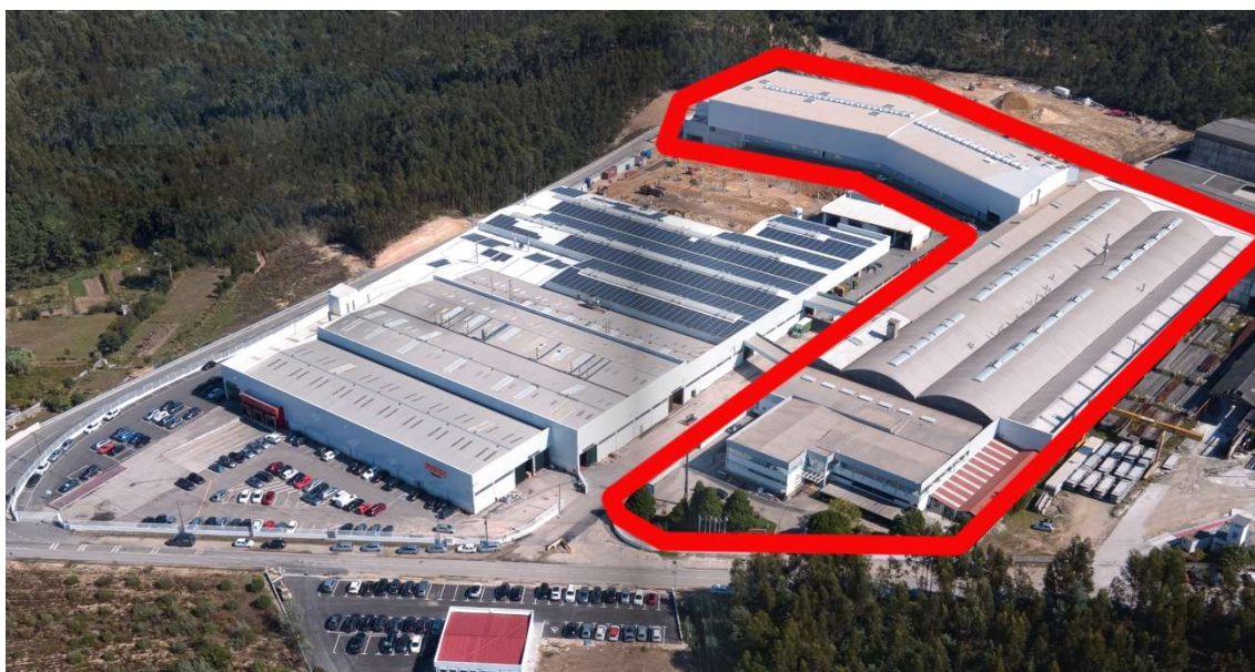
Figura 2.1 – Vista geral da RODI Industries em 2022 com as instalações da RODI Cycling.
