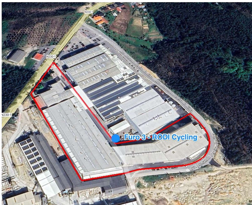
Figura 3.31 - Localização do furo para utilização na linha de anodização.
