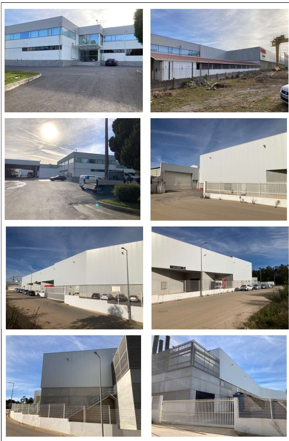
Figura 3.10 - Configuração exterior dos pavilhões industriais existentes.
