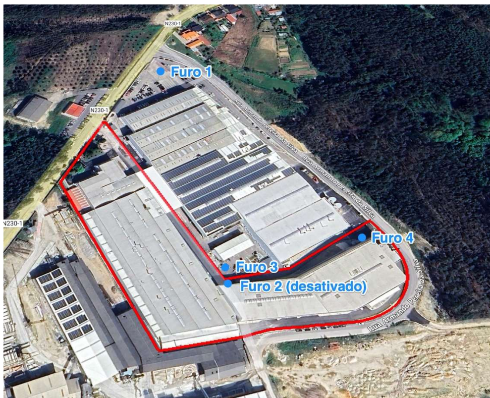
Figura 4.6.10 – Furos existentes na RODI Industries.
