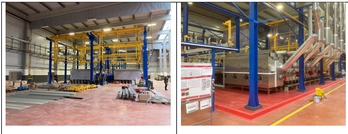
Figura 7 – Montagem dos equipamentos das linhas de pintura e anodização.
