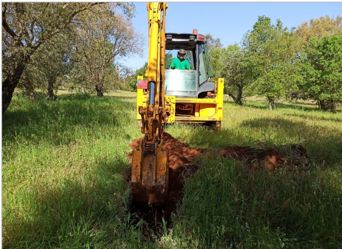
Figura 5.4 - Abertura do poço de reconhecimento P1.
