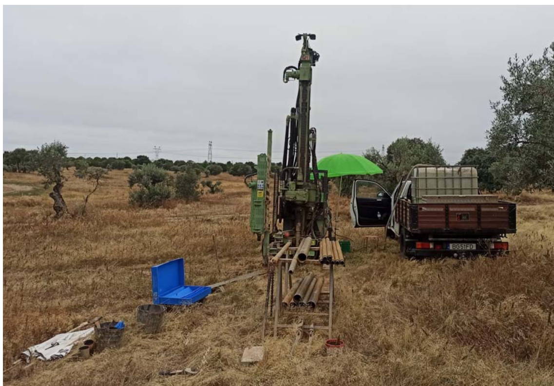
Figura 5.1 - Equipamento utilizado na furação na sondagem S4-Pz.
