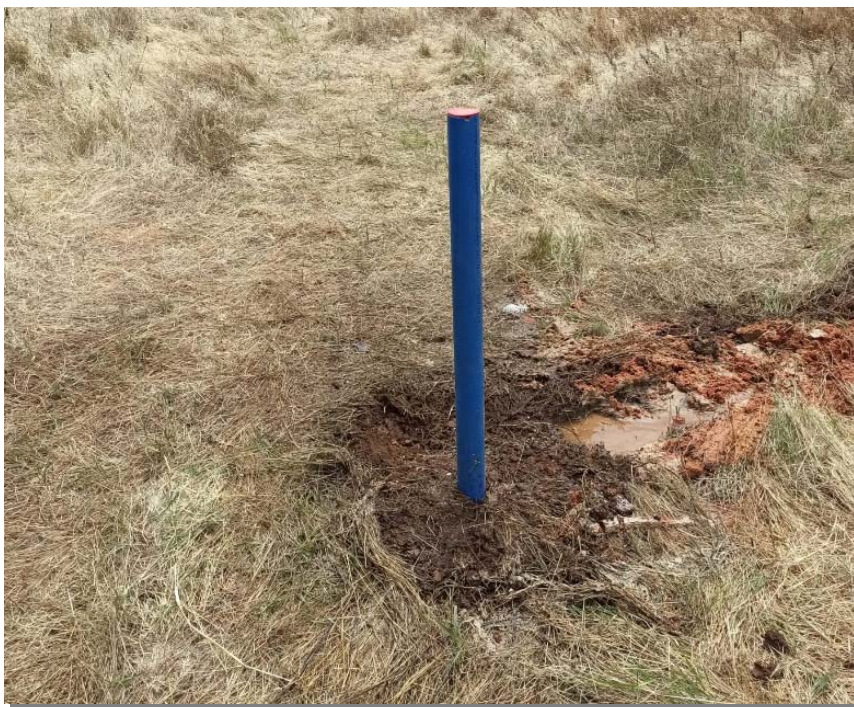
Figura 5.3 - Pormenor do piezómetro instalado na sondagem S4-Pz.
