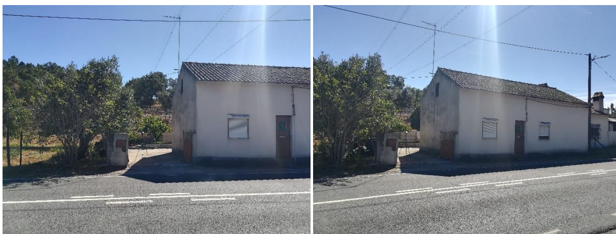
Figura 2 – Apontamento fotográfico Ponto 1
