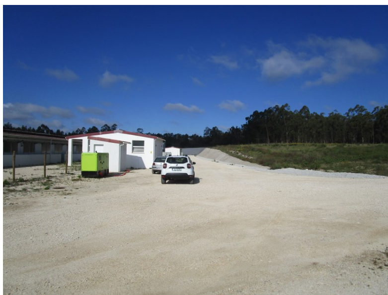
Figura 1 - Vista geral dos pavilhões já construídos (solo artificializado)
