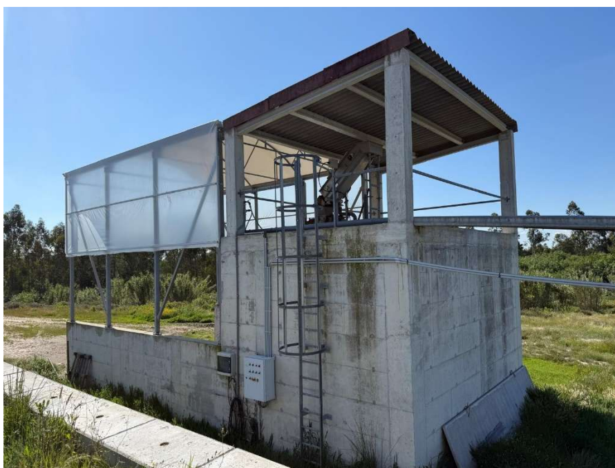
Figura 8.9 – Vista exterior para o tamisador existente
