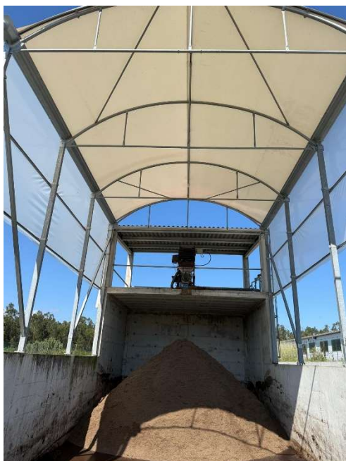
Figura 8.7 – Vista para o tamisador existente
