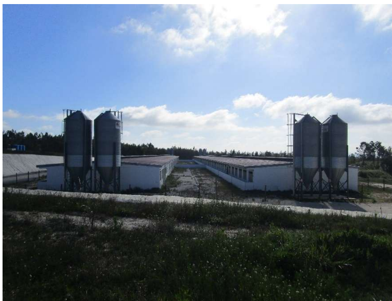
Figura 7.67 – Vista geral dos pavilhões já construídos e dos acessos (solo artificializado)
