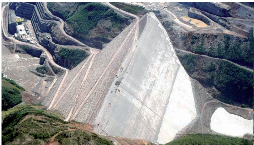
Figura 5.5 – Paramento de jusante em barragens de enrocamento entrecortado por banquetas configuradas pelos acessos de construção.
