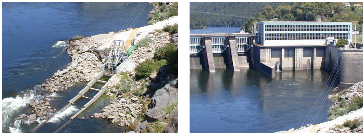
Foto 4.4 – Teleférico de peixes instalado na barragem da Frieira (à esquerda pormenor das bacias e à direita cabos que transportam a cuba e contornam a barragem).
