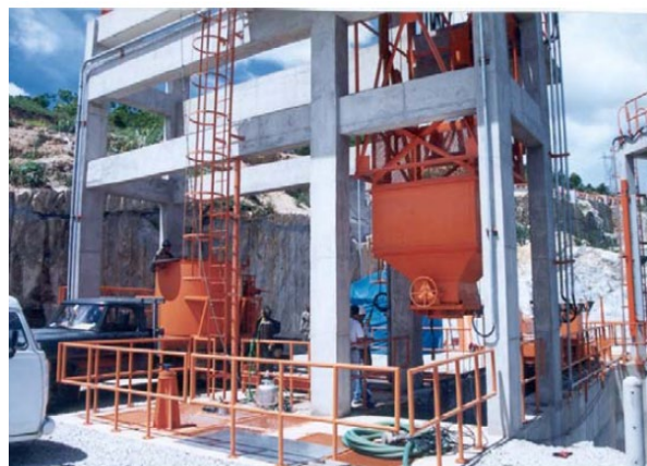
Foto 4.5 – Exemplo de sistema de transposição trap and truck (Fontes: Hinze, 2007 à esquerda e Pompeu e Martinez, 2005a à direita).
