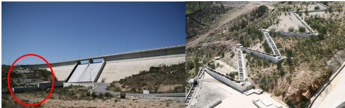
Figura 5.1 – Barragem de Pretarouca. Dispositivo de transposição piscícola. (Fonte: https://teixeiraduarteconstrucao.com/projetos/barragem-de-pretarouca/ ).
