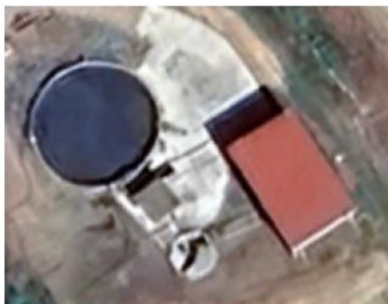
Fotografia 3.8 - Separador de sólidos e nitreira.
