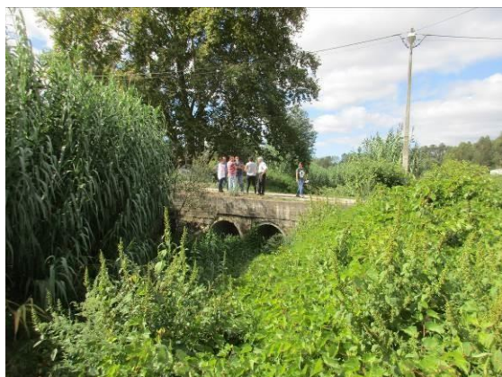
Fotografia 3.2 - Atravessamento da linha de água.
