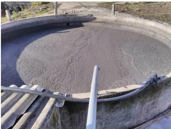
Fotografia 3.7 - Tanque de recepção.
