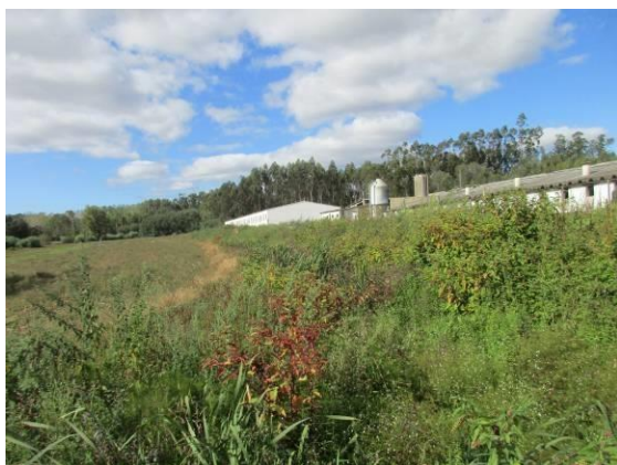
Fotografia 4.6 - Vista para a vala de drenagem - norte.
