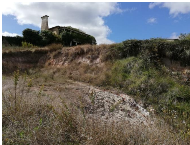
Fotografia 4.1 - Talude de escavação dentro da propriedade (próximo da habitação), onde afloram arenitos.
