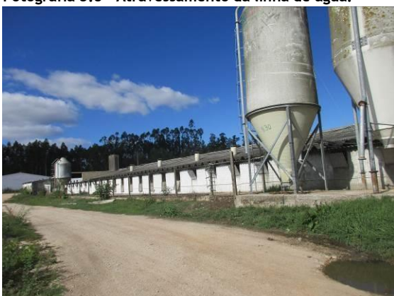
Fotografia 3.7 - Edifício afeto à recria.
