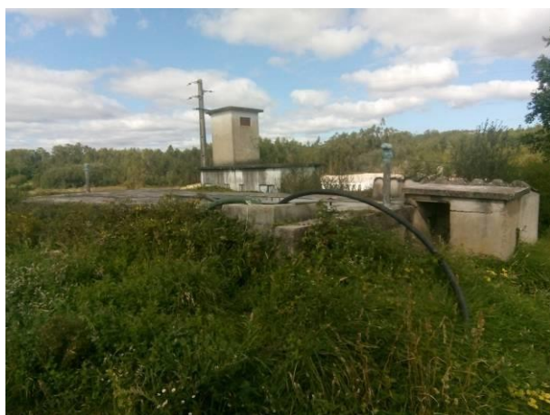
Fotografia 4.2 - Furo de captação de água subterrânea existente na área do projeto para consumo humano e produção pecuária.
