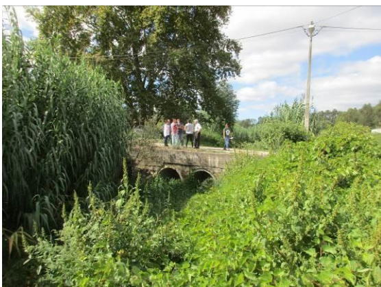
Fotografia 3.5 - Atravessamento da linha de água.
