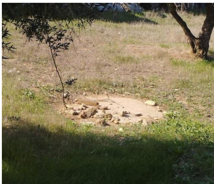
Figura 8: Exemplo de fossa existente a sobreelevar.
