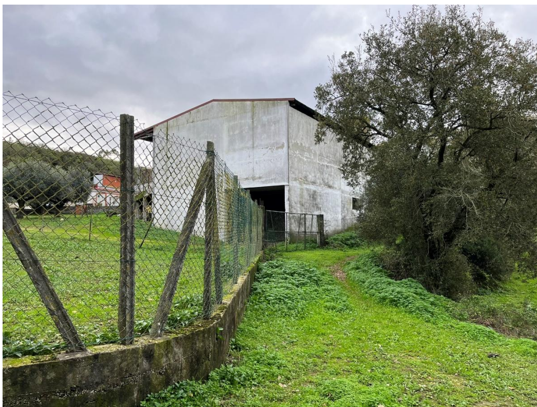
Figura 3.1.6. Pavilhão de armazenamento temporário de estrume
