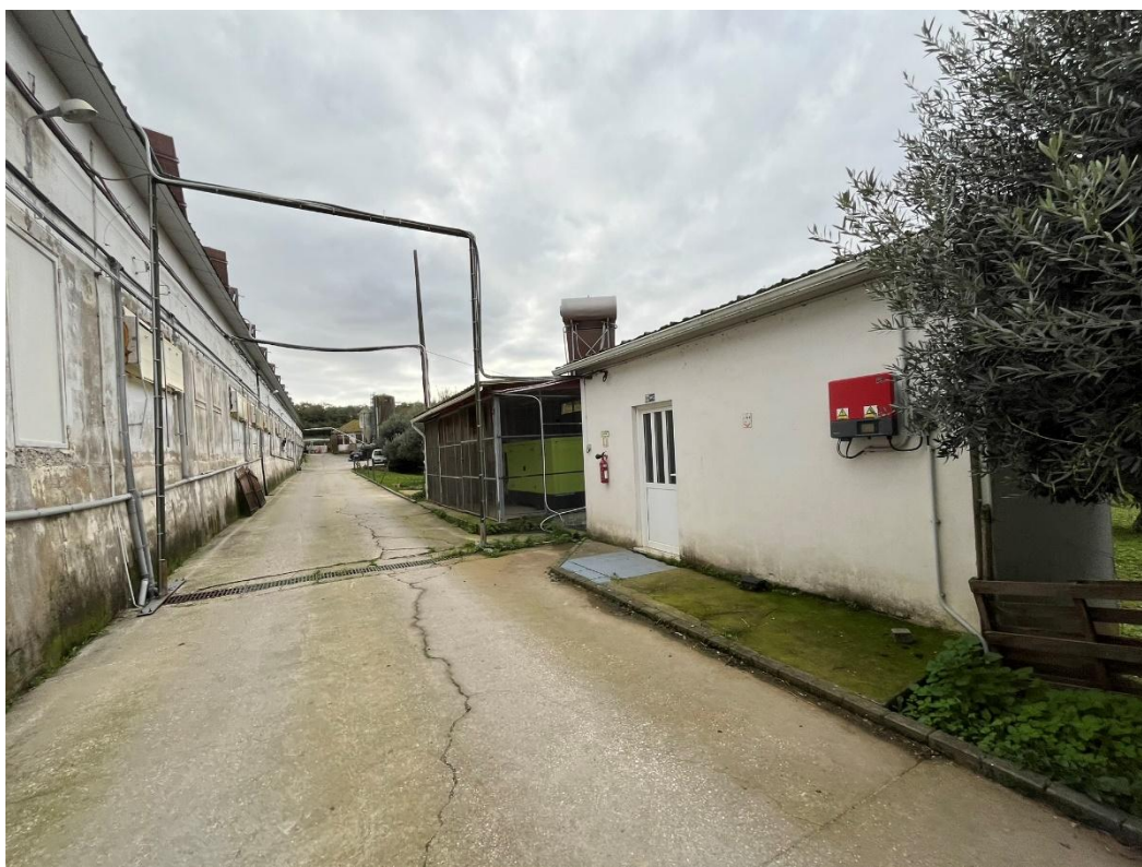
Figura 3.1.2. Arco de Desinfecção e Filtro Sanitário
