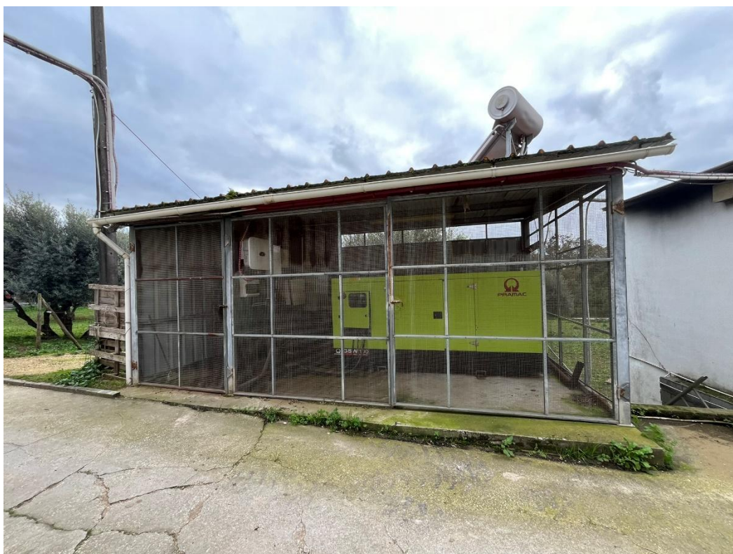
Figura 3.1.3. Casa do Gerador
