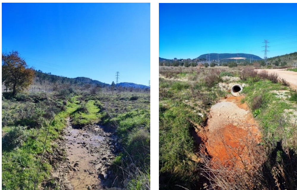
Figura 4.3.3. Aspeto do Ribeiro de Camporez junto à área de projeto (Foto tirada em 24/01/2023).
