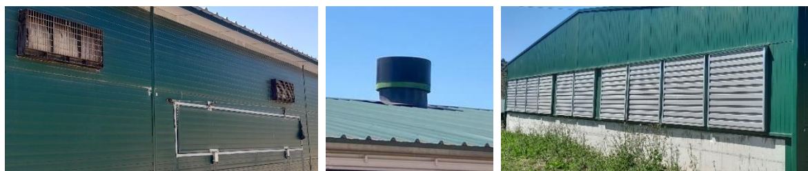
Figura 3.4.5. Equipamentos de ventilação: lateral (esquerda); de teto (centro); de fundo (direita).
