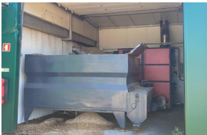
Figura 3.4.2. Gerador de ar quente existente na instalação, semelhante ao que será instalado.
