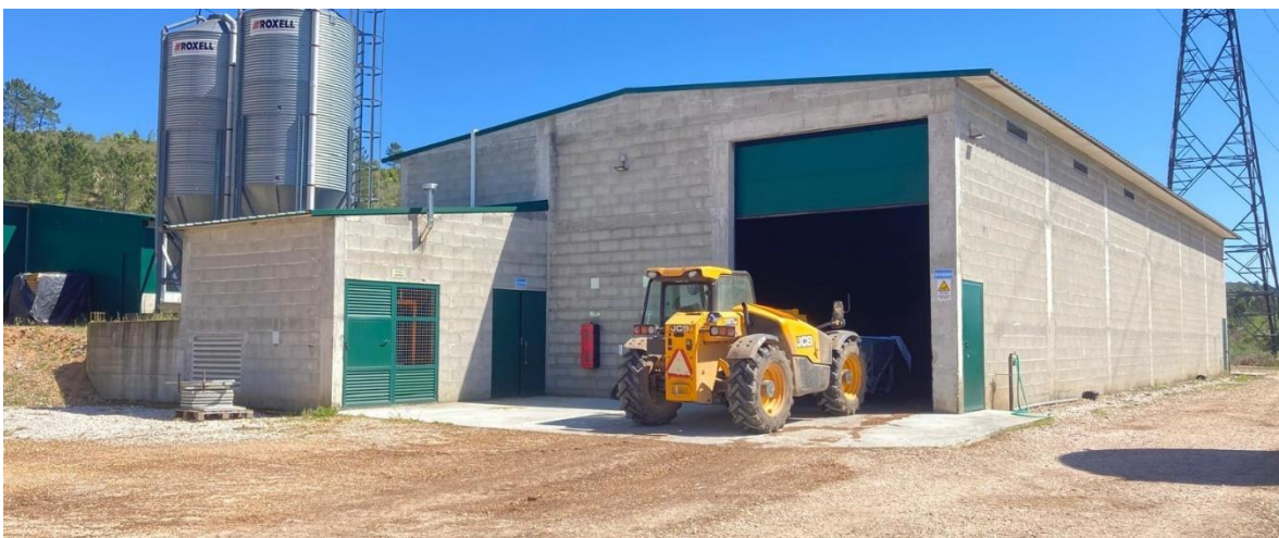
Figura 3.1.2. Edifício de armazéns existente (8).
