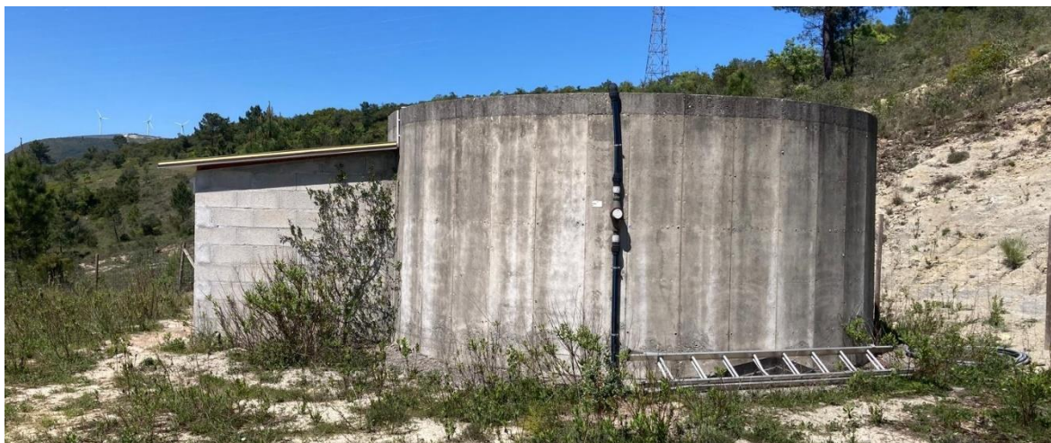
Figura 3.1.4. Reservatório de água existente (12).
