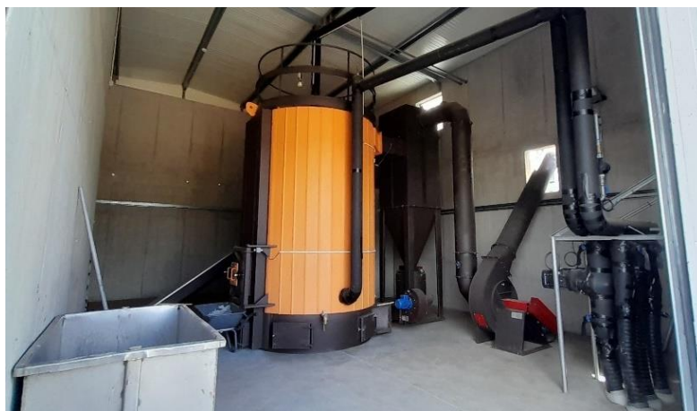
Figura 3.4.3. Caldeira de água quente semelhante às que serão instaladas.
