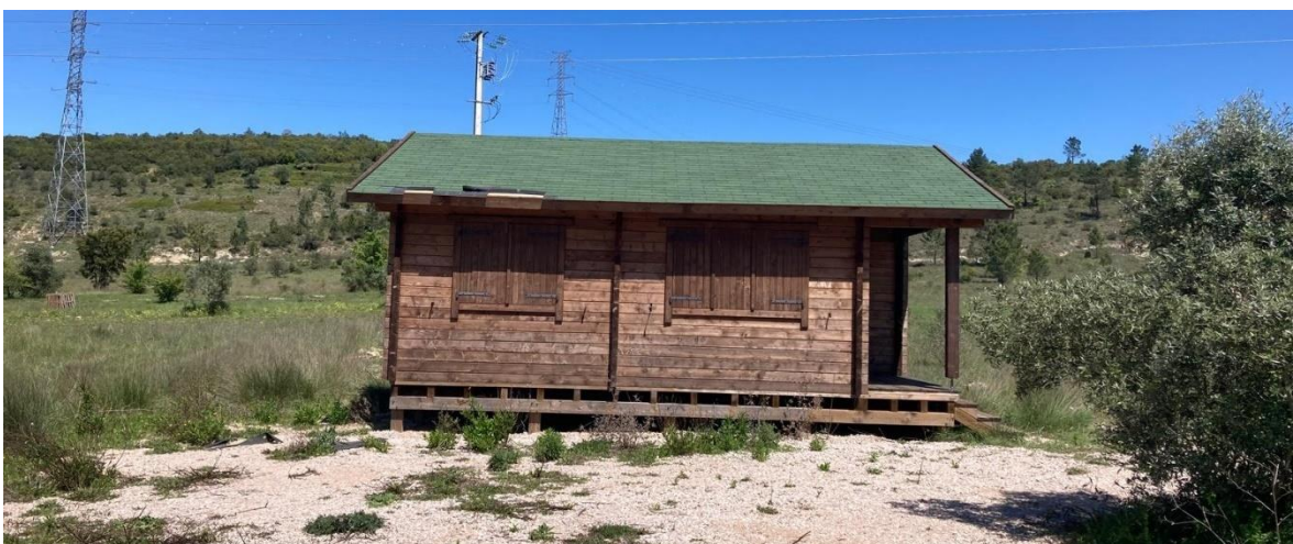
Figura 3.1.3. Casa de madeira existente (11).
