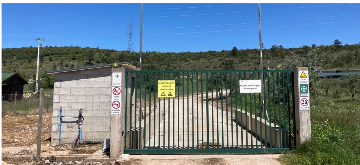
Figura 3.1.5. Edifício de apoio ao arco de desinfecção existente (14).
