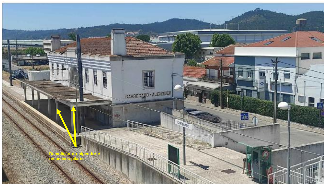
Figura 7 – Demolição de alpendre voltado para a linha férrea e respetivos pilares
