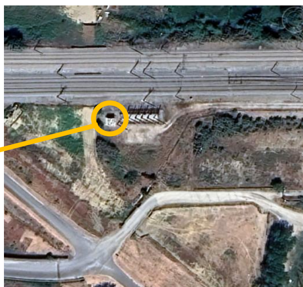
Figura 8 – Posto de Catenária Carregado Norte (existente)
