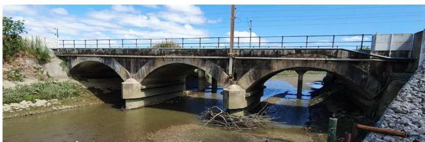
Figura 15 – Ponte sobre a Vala do Carregado – Ponte de Alvenaria Existente – zona a poente da linha férrea (lado terra) – a demolir e a substituir por nova
