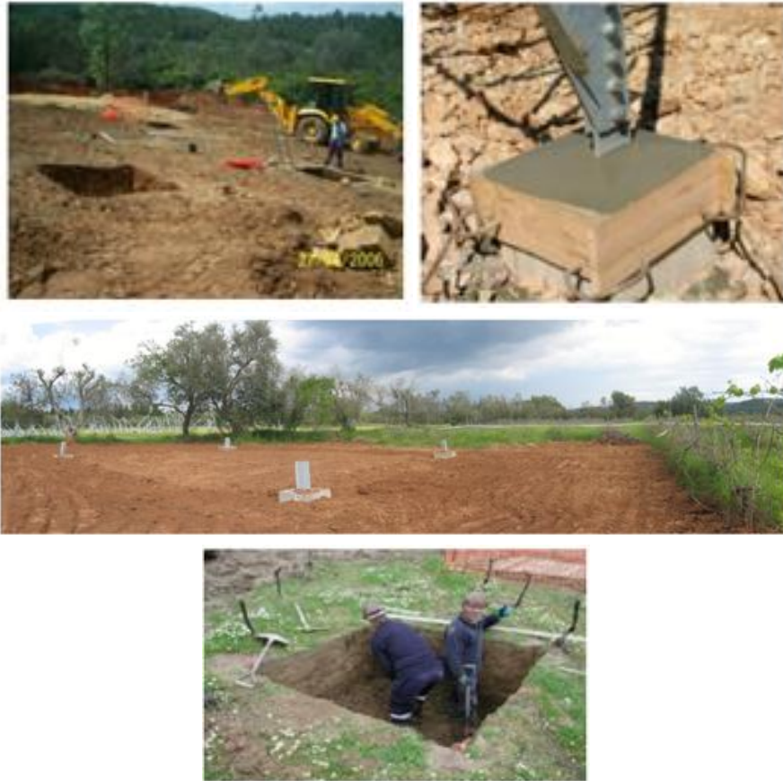
Figura 6 – Execução das fundações dos apoios de linha.
