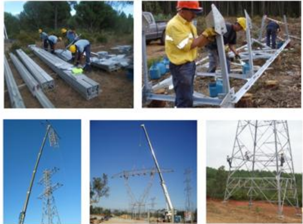
Figura 7 – Montagem dos apoios de linha.
