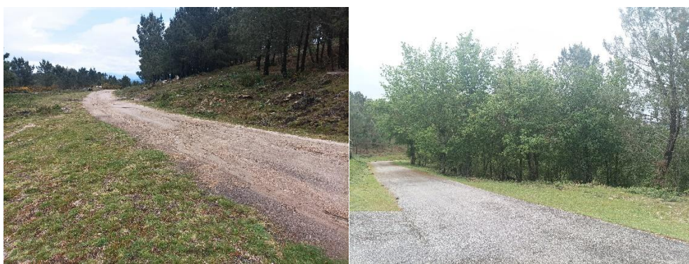
Fotografia 3.1 – Tipologia de acessos existentes sem necessidade de beneficiação
