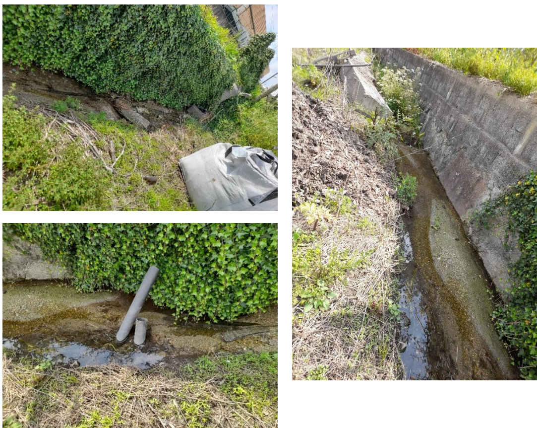
Figura 17: Canal de escoamento de águas pluviais
