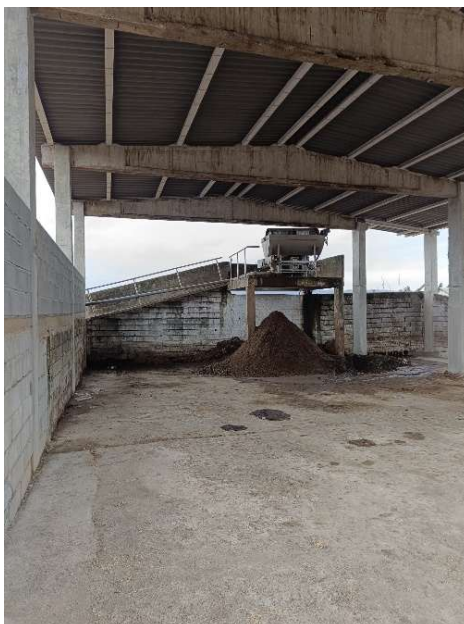
Figura 1 - Vista para a nitreira existente
