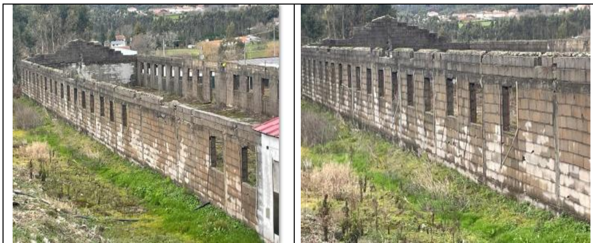
Figura 6.1 e Figura 6.2 - Pavilhão I – Pavilhão iniciado (Reserva) desativado
