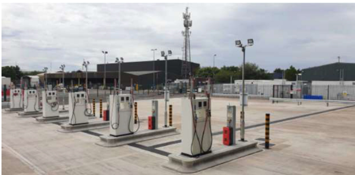
Figura 17 Exemplo de conjunto de Estações de Enchimento de Trailers de BioGNC (Fonte RS do EIA)
