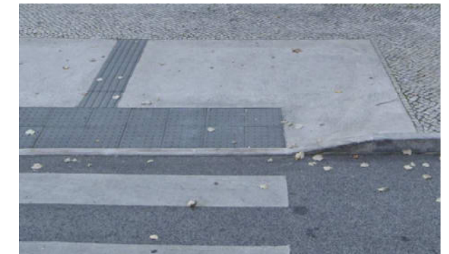
ESQUEMA ILUSTRATIVO Características e dimensionamento da moldura de contraste – betão “ in situ ”
