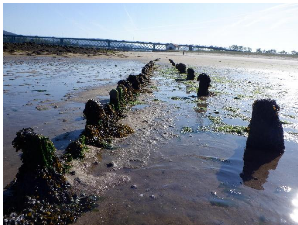
Figura 222 –Alinhamento de estacaria em madeira (PVC1)
