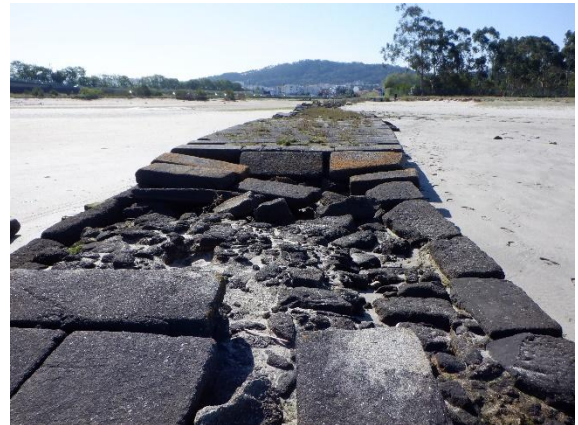
Figura 224 – Pormenor de sistema construtivo de cais de S. Lourenço (PVC4)
