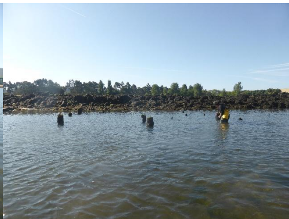
Figura 220 –Vestígios de estacaria da antiga ponte (PVC2) junto ao marachão (PVC3).
