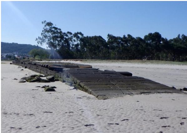
Figura 223 – Rampa de varadouro de cais de S. Lourenço (PVC4)
