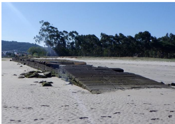
Figura 228 – Rampa de varadouro de cais de S. Lourenço (PVC4)
