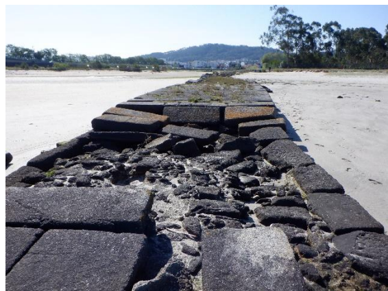
Figura 229 – Pormenor de sistema construtivo de cais de S. Lourenço (PVC4)
