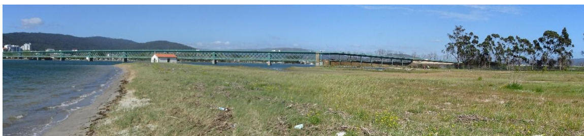
Vista para nascente. Ao fundo a Capela de S. Lourenço
