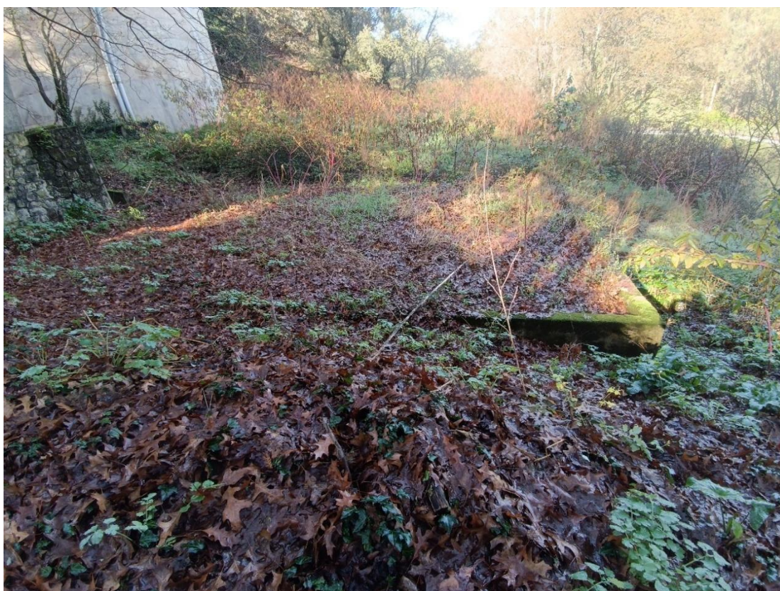
Figura 18. Infraestruturas em betão cobertas por vegetação, correspondendo a antigos tanques (Vista 2 da Figura 16).
