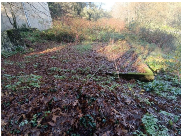
Figura 4. Infraestruturas em betão cobertas por vegetação, correspondendo a antigos tanques (Vista 2 da Figura 2).
