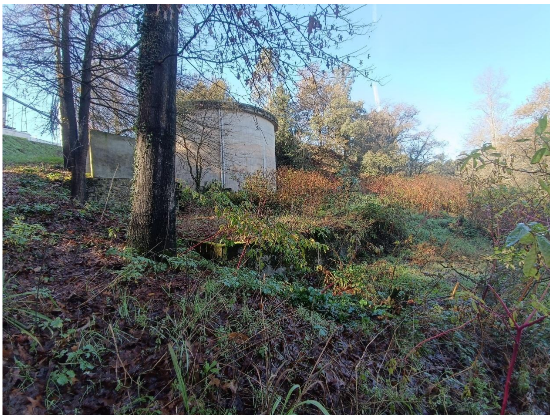
Figura 17. Infraestruturas em betão cobertas por vegetação, correspondendo a antigos tanques, e tanque redondo grande (Vista 1 da Figura 16).
