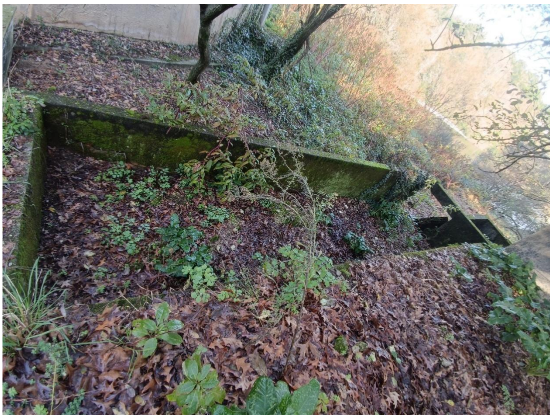
Figura 19. Infraestruturas em betão cobertas por vegetação, correspondendo a antigos tanques (Vista 3 da Figura 16).
