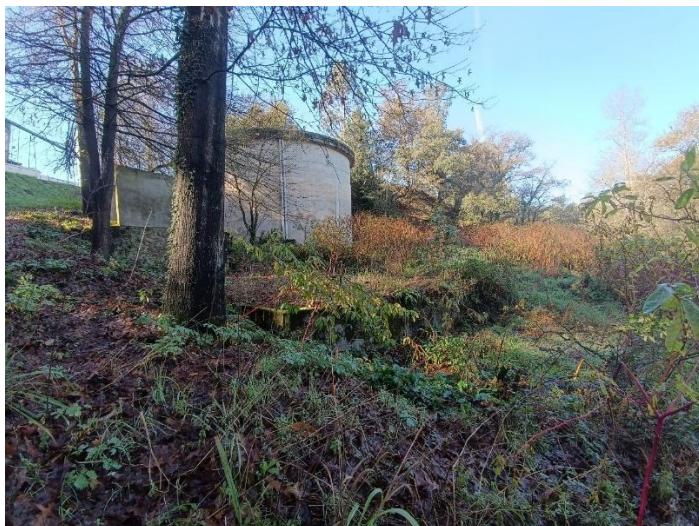
Figura 3. Infraestruturas em betão cobertas por vegetação, correspondendo a antigos tanques, e tanque redondo grande (Vista 1 da Figura 2).
