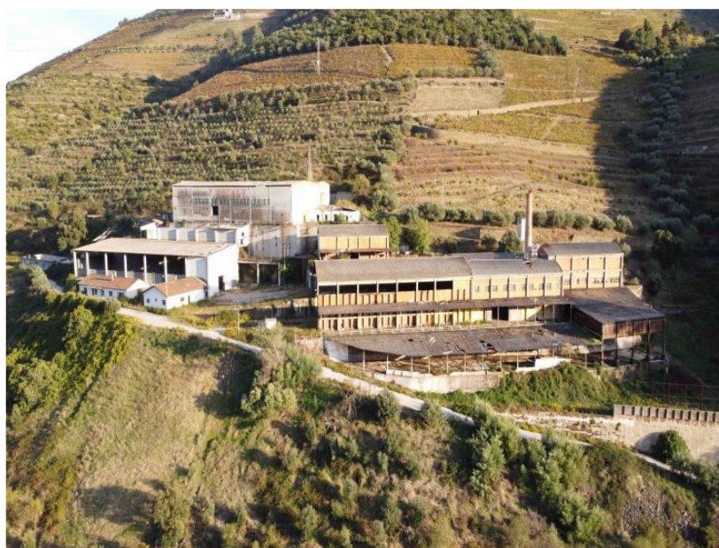
Fig-35 Vista da Situação Existente
