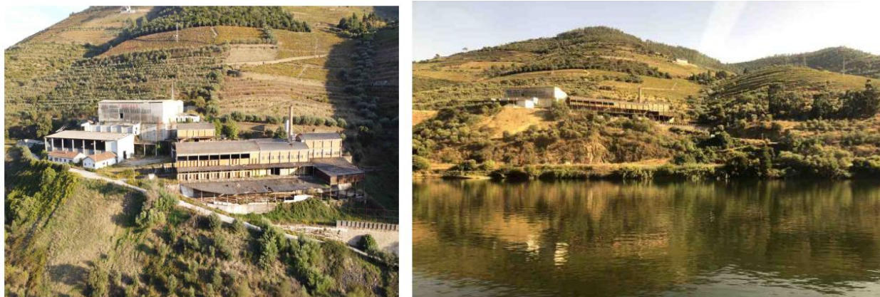
Fig-13 Vistas da situação existente (Fonte: aditamento ao EIA)
