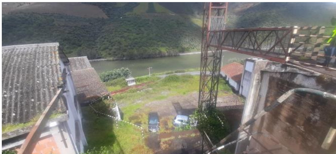
Fig-24 Fotografias das estruturas da unidade fabril no local do HQP (Fonte: própria)
