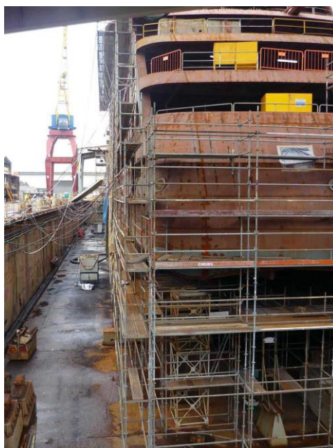
FIG. 5 - Plataforma de construção
