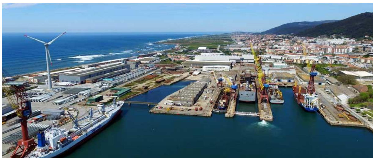
FIG. 10 - Perspetiva sobre a área do estaleiro naval
