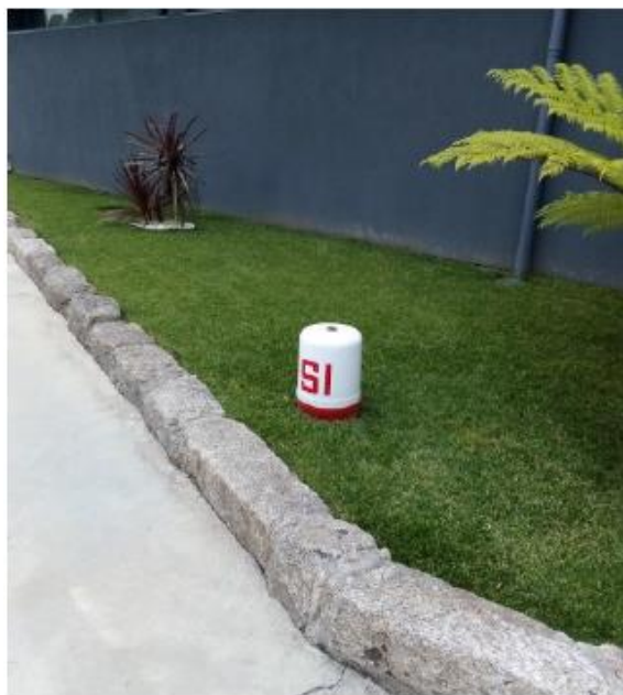
Figura 15 – Marco de incêndio no interior do recinto
