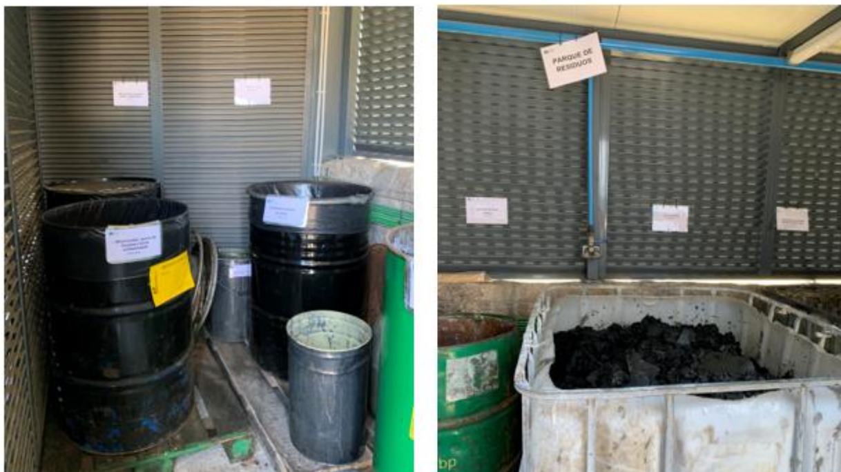
Figura 12 – Parque de resíduos
