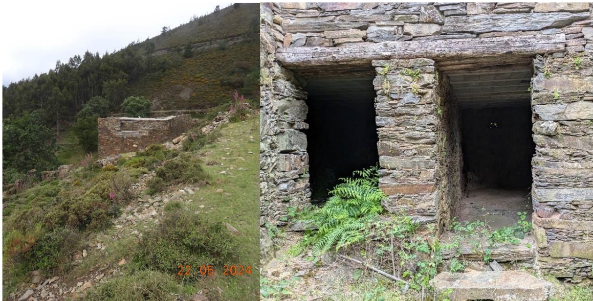
Figura 4.49 – Ruína parcialmente recuperada e piso térreo em Silveira de Cima
