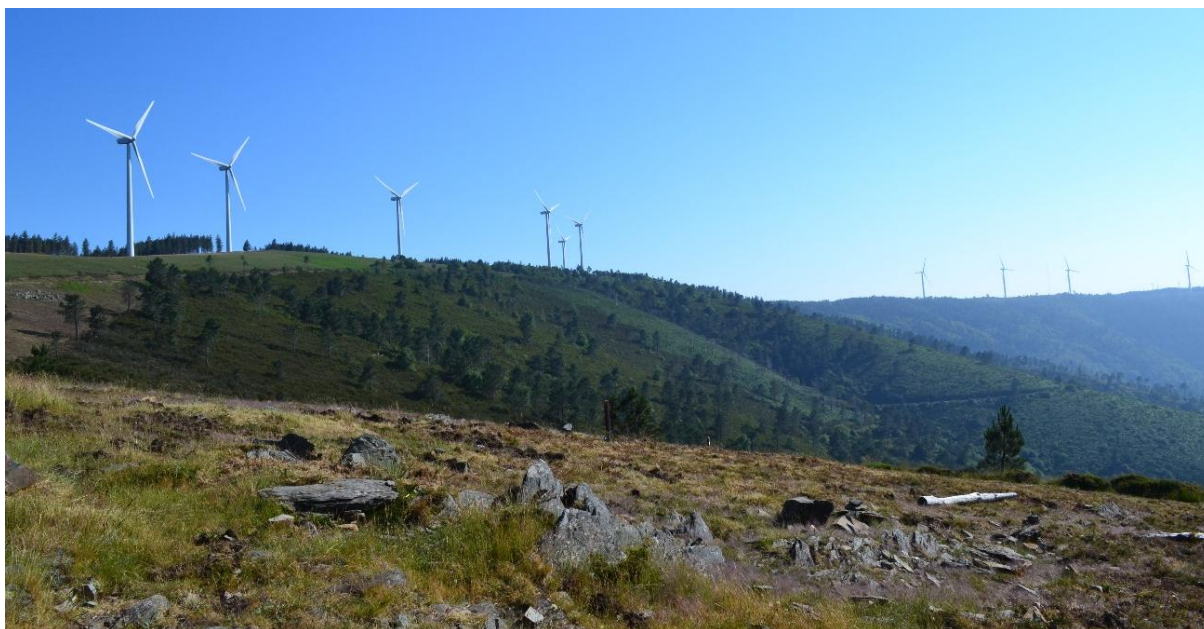
Figura 4.75 – Cumeadas na SUP 1 com presença dos aerogeradores do Parque Eólico da Serra da Lousã
