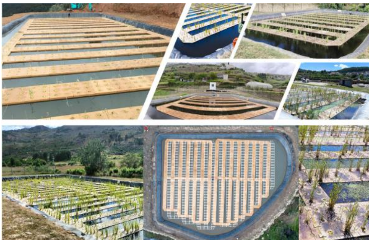
Figura 3.38 – Exemplo de ETAR de Lagoa de Ilhas Flutuantes em Cortiça com macrófitas
