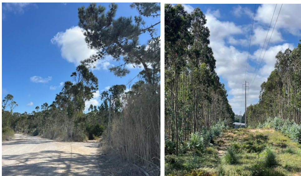
Figura 10 - Estrada de Braçais (à esquerda) e linha elétrica (à direita). Fonte: Visita CA no dia 11/08/2026
