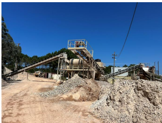
Figura 12 - Unidade Industrial que serve a Concessão Casal dos Braçais. Fonte: Visita CA no dia 11/08/2026
