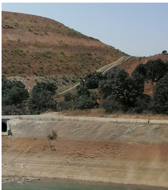
Figura 39 – Vala de drenagem da BE-BAC com características semelhantes às valas propostas, embora de menor dimensão. Fonte: Visita da CA dia 18/08/2026
