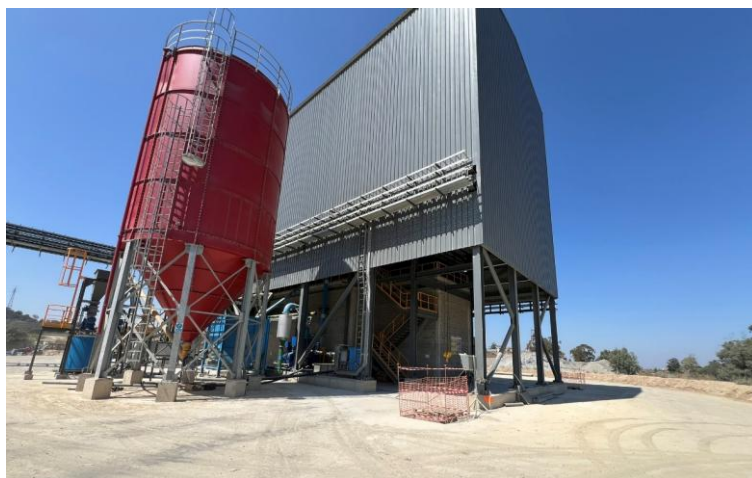
Figura 30 - Central de Pasta na Concessão C-9 “Aljustrel”. Fonte: Visita da CA dia 18/08/2026
