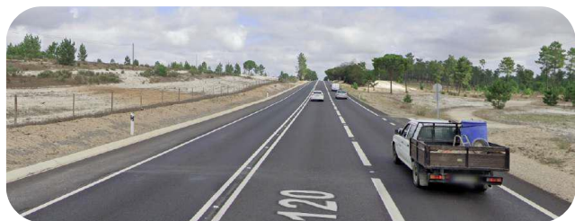
Fig. 7 - Local de implantação do futuro desnivelamento.
