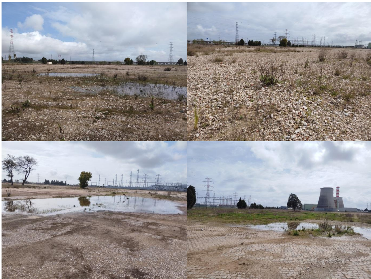
Fotografia 2.6, 2.7, 2.8 e 2.9 – Terrenos terraplanados após demolição do setor poente da Central.
