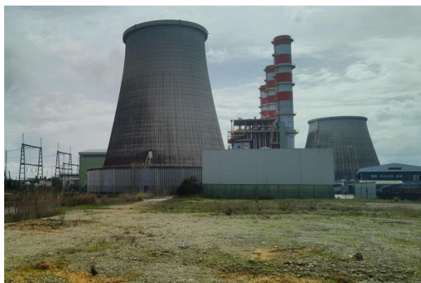
Fotografia 2.12 – Aspetos das infraestruturas existentes.
