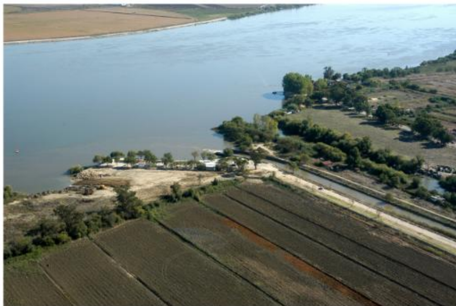
Figura 2.2 – Canal de rejeição e ponto de descarga da antiga Central Termoelétrica do Carregado
