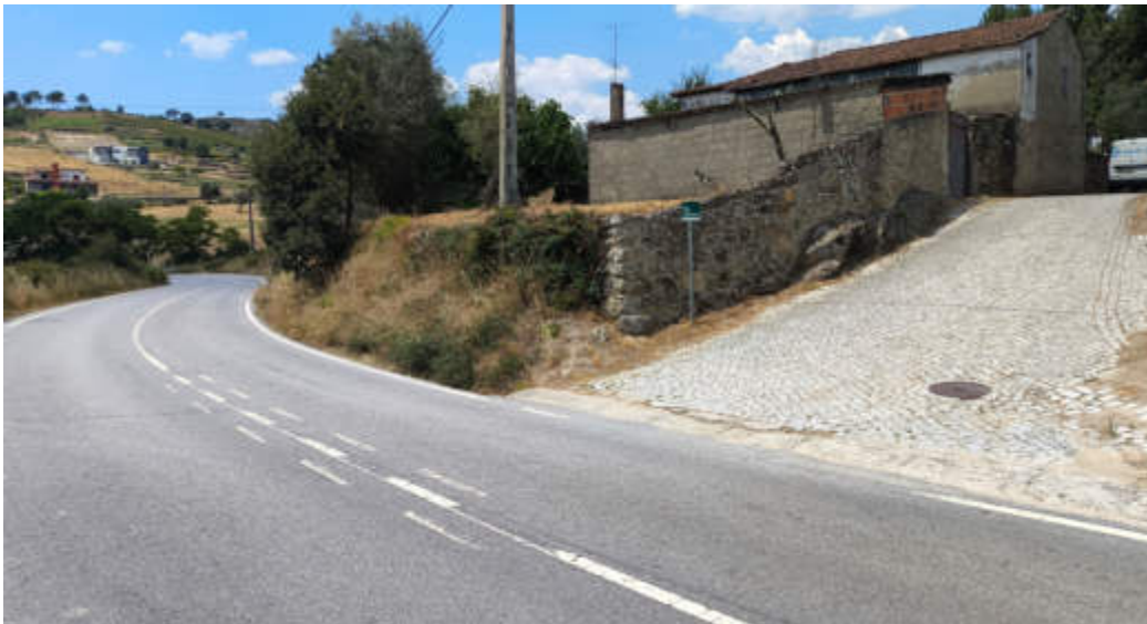
Imagem 3 – cruzamento sem visibilidade no acesso à E.N. 103.
