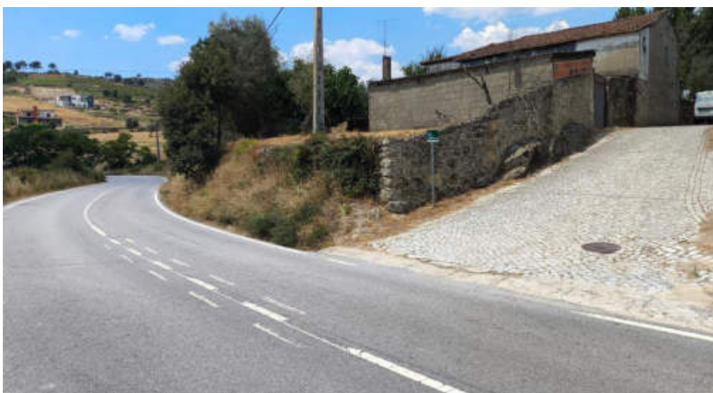
Figura 28 - Cruzamento sem visibilidade no acesso à E.N. 103.
