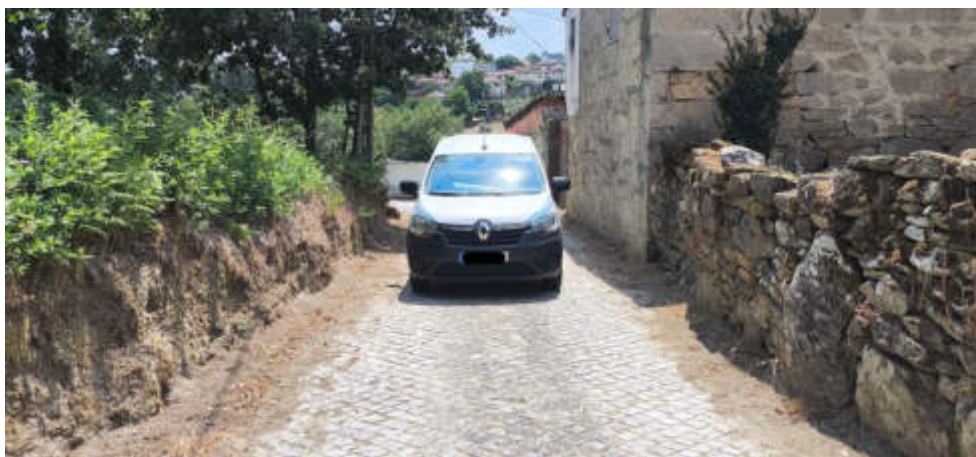
Figura 27 - Caminho existente é demasiado estreito para o cruzamento de 2 veículos.
