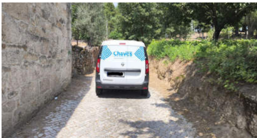
Figura 26 – Caminho existente é demasiado estreito para o cruzamento de 2 veículos.
